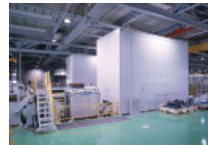
防音パネル設置後のプレスライン（中井事業所）
