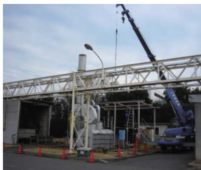
つくば事業所の焼却炉解体、撤去
