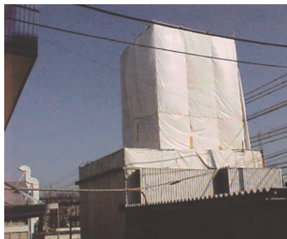
追浜事業所の焼却炉解体、撤去
