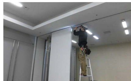
移動間仕切りの点検の様子
