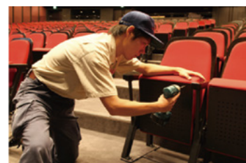
劇場・ホール椅子の修理
