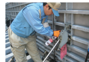
防水板の点検・修理
