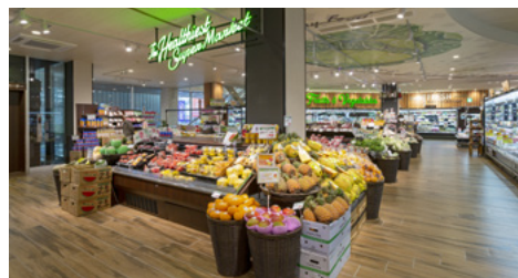
スーパーマーケット・冷凍冷蔵ショーケース
