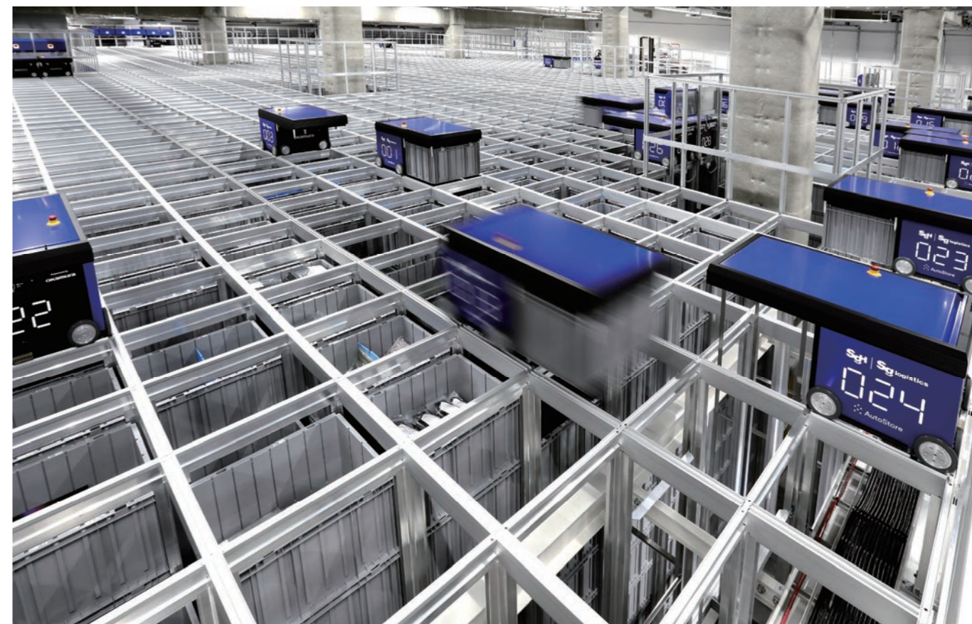
CMや広告にも登場した青いコーポレートカラーのロボットが稼働するオートストア。SKUが多い複数事業者の低～中頻度品を保管している。
